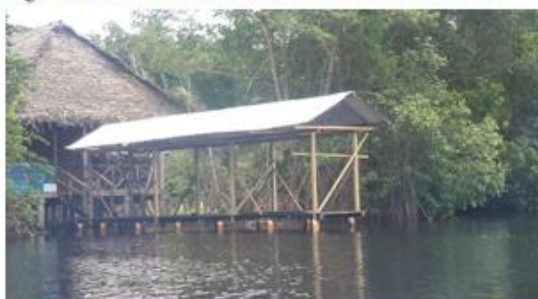
Centro de Visitantes Santa Isabel mejorado su muelle con techo
